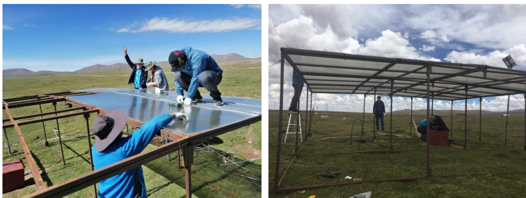
Рис.9. Моменты сооружения экспериментальной установки по исследованию влияния инфильтрации жидких атмосферных осадков на термовлажностный режим грунтов в условиях Тибетского плато
