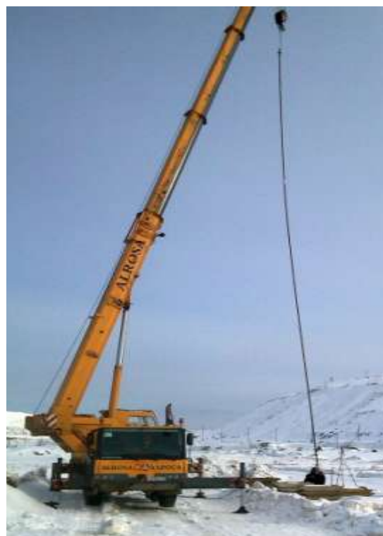
Спуск установки в скважину
